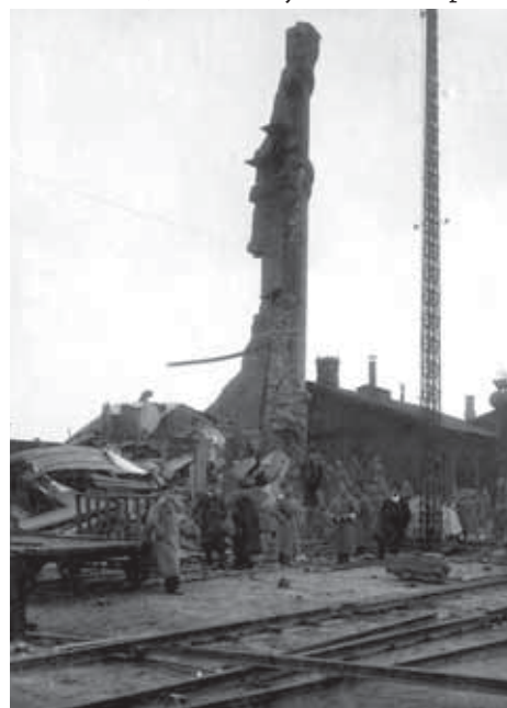
Resztki wieży wodnej na Dworcu Fabrycznym. Fot. ze zbiorów Archiwum Państwowego w Łodzi
