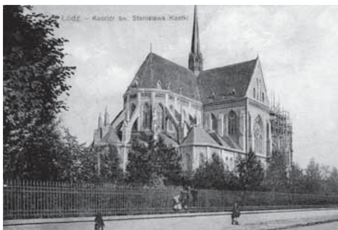
Kościół św. Stanisława Kostki. Widoczne rusztowania w miejscu budowanej wieży. Fot. ze zbiorów H. Poselta
