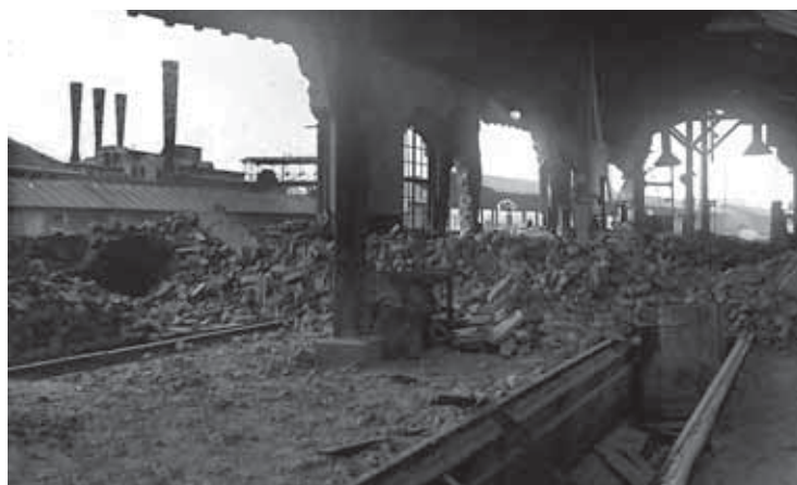
Zniszczony budynek warsztatów kolejowych na Dworcu Fabrycznym. Fot. ze zbiorów Archiwum Państwowego w Łodzi
