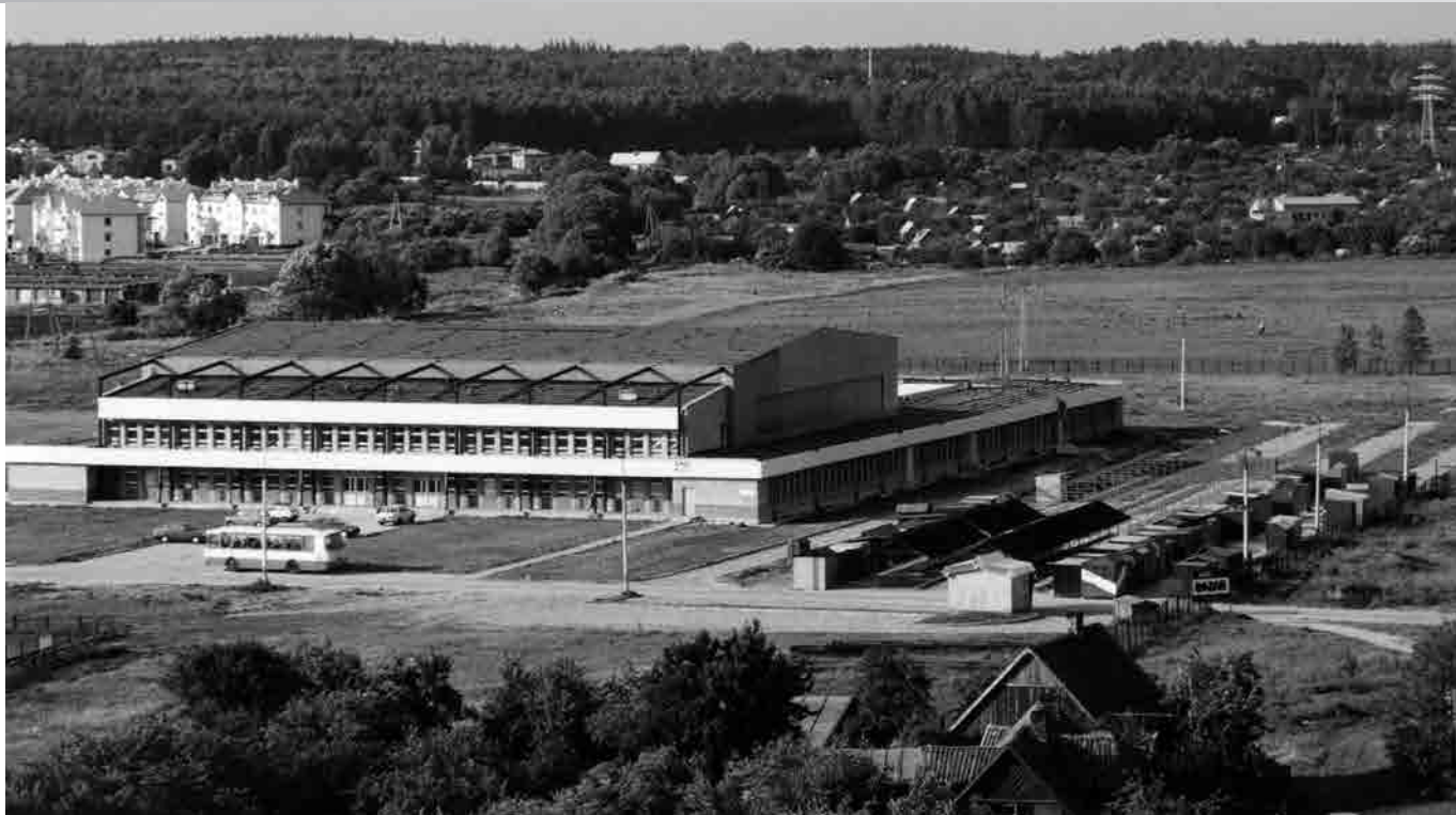
Widok ogólny na halę sportową od zachodu General view of the sports hall from the west
