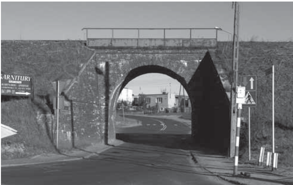
Ryc. 30. Ceglany wiadukt sklepiony w Luboniu, typowy dla obiektów linii Wolsztyn – Luboń, 2011
