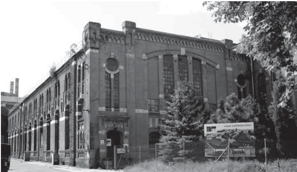
Diettmar, elektrownia-hala turbin, 1906-1907 fot. K. Stefański
