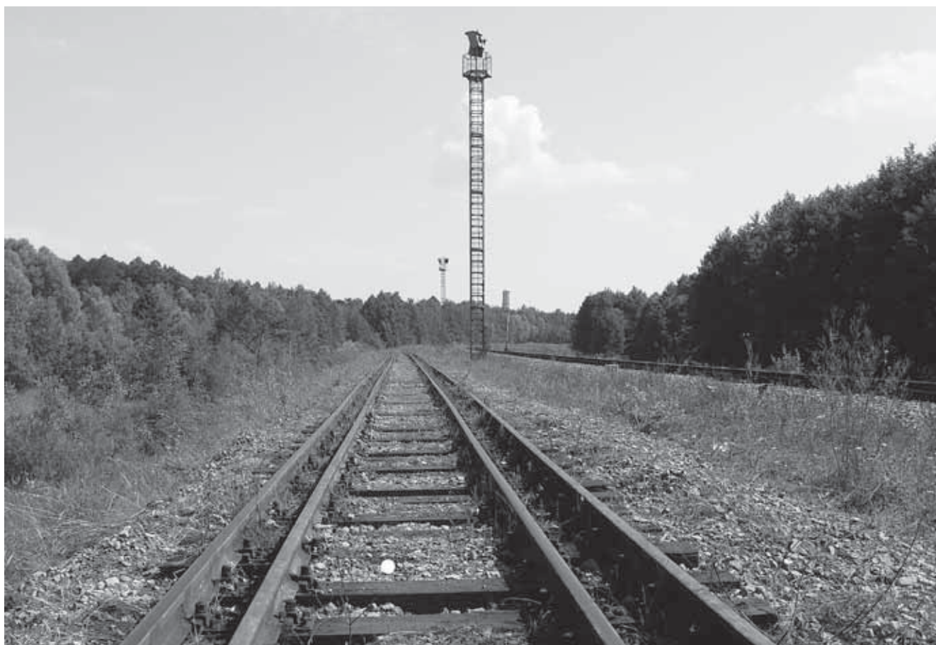
Zdj. 1. Połączenie, tzw. splot torów rozstawu normalnego i szerokiego. Różnica szerokości jest niezauważalna gołym okiem – wynosi zaledwie 85 mm, czyli nieco ponad szerokość główki szyny. Z tego względu sploty tego typu realizuje się w postaci czterech szyn ułożonych na przemian dla każdego z rozstawów (w tym przypadku pierwsza i trzecia, patrząc od lewej to tor normalny, a druga i czwarta tor szeroki).
