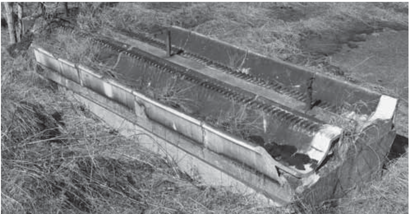
Fot. 184. Relikty otwartej umywalni wojskowej na rampie Wehrmachtu (fotografia z 2010 r.)
