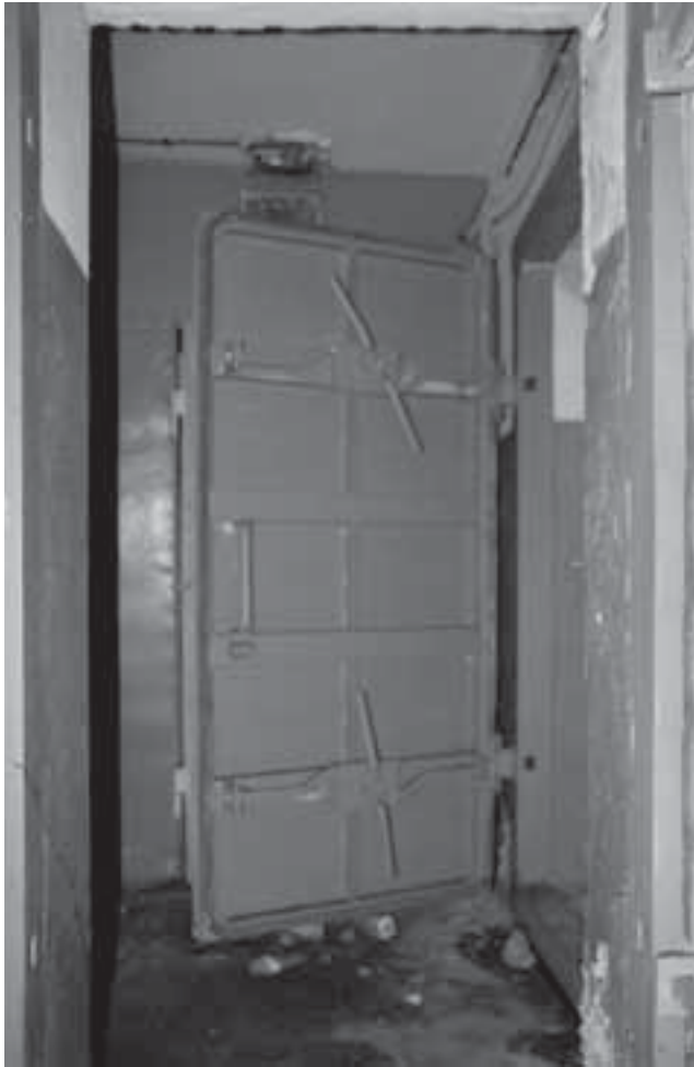
Fot. 88. Śluza powietrzna w schronie pod budynkiem warsztatowo-administracyjnym wagonowni (fotografia z 2009 r.)
