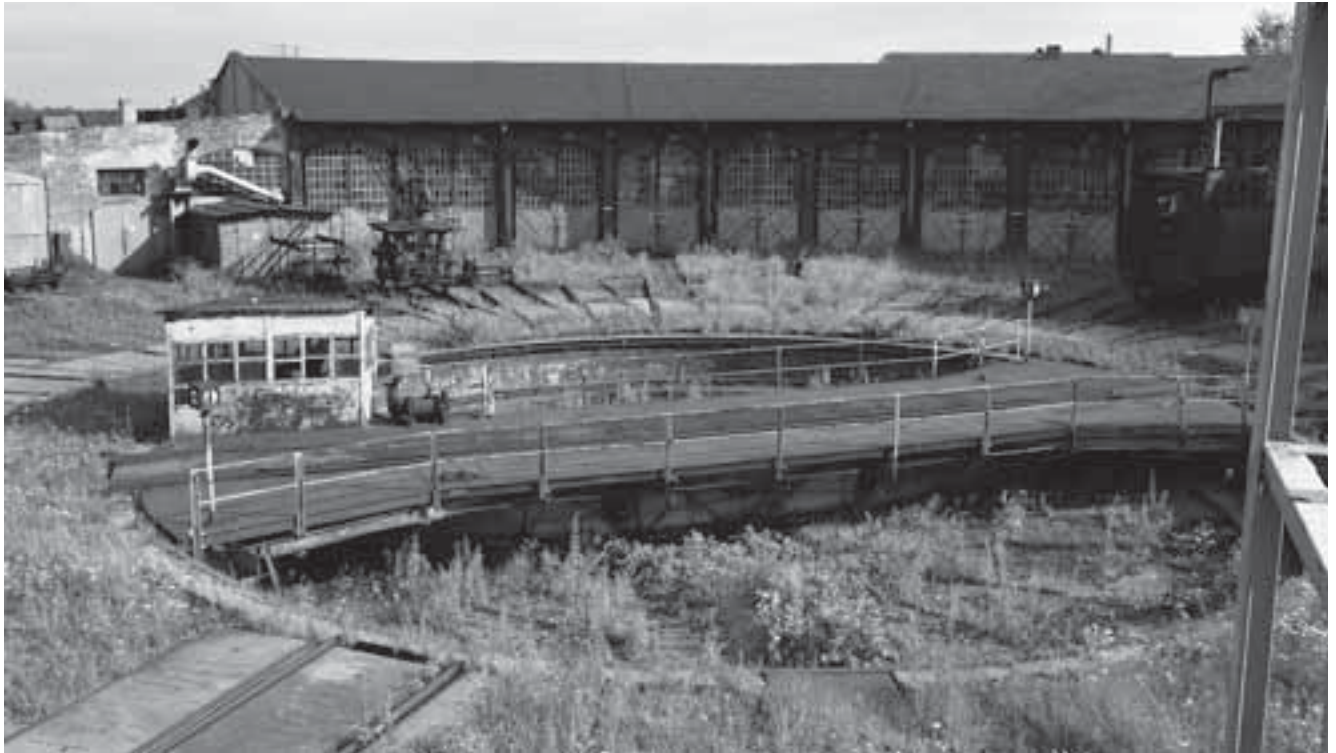
Fot. 118. Obrotnica i najstarsza część mniejszego kompleksu lokomotywni (fotografia z 2009 r.)
