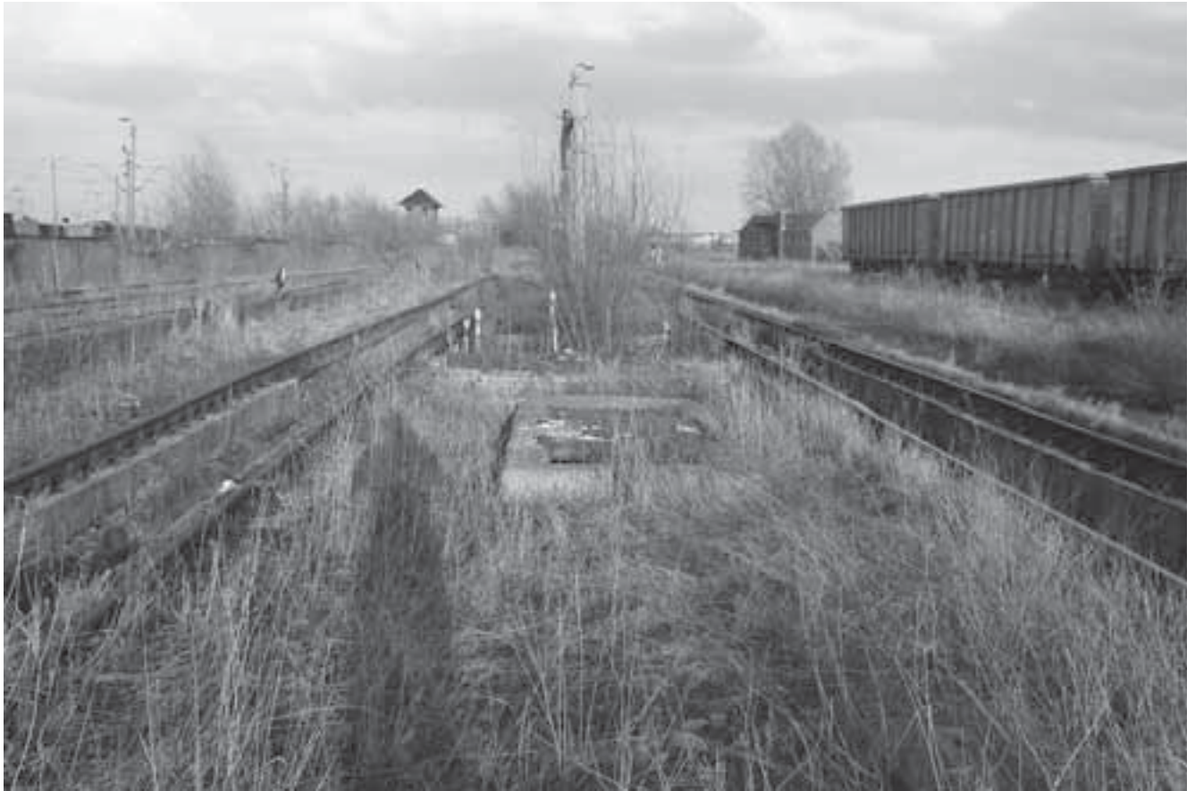
Fot. 174. Dwutorowy kanał oczystkowy z zachowanym żurawiem wodnym (fotografia z 2010 r.)
