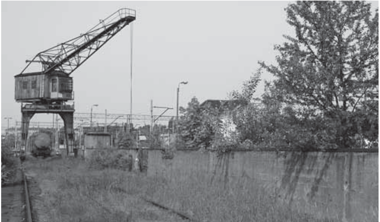
Fot. 169. Żuraw węglowy i zasięg węglowy (fotografia z 2009 r.)
