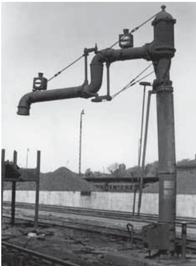
Fot. 57. Nowoczesny żuraw wodny z przegubowym rękawem, zainstalowany w obrębie kanału oczysztkowego w zespole ciągu technicznego obrządzania lokomotyw (fotografia z lat 50. XX w.)
