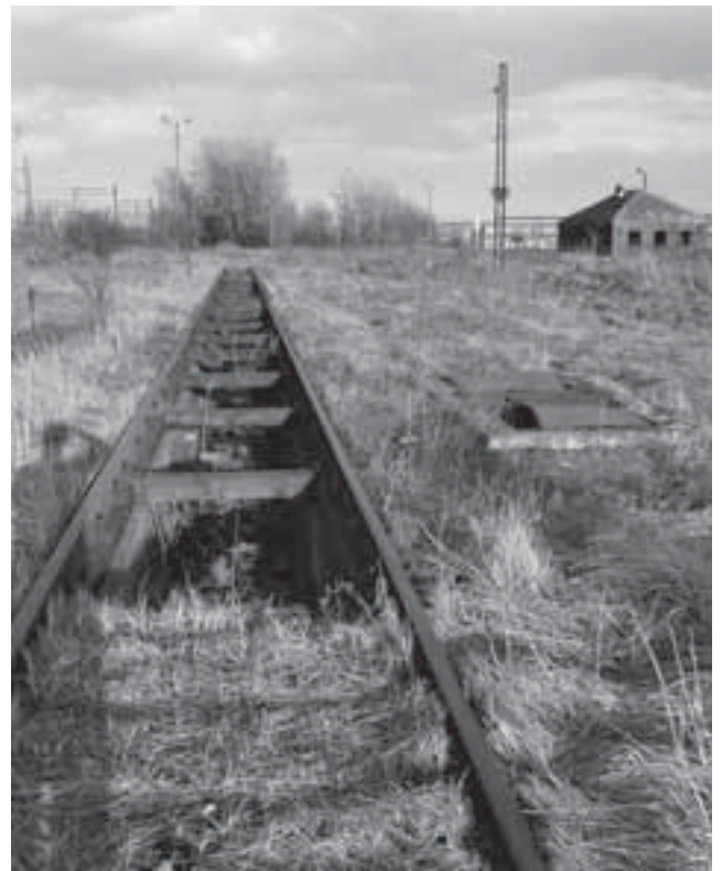
Fot. 175. Oryginalna konstrukcja rezerwowego kanału oczystkowego (fotografia z 2010 r.)
