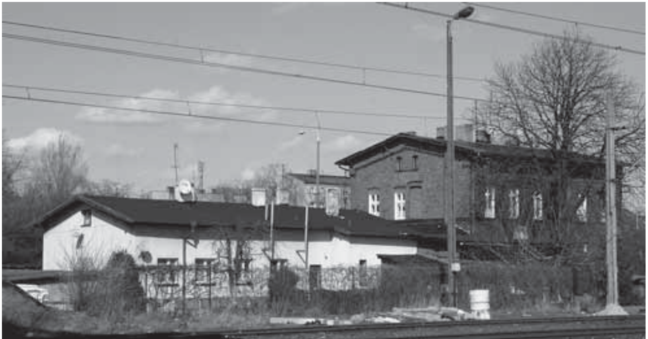
Fot. 6. Dom urzędników Górnśląskiego Towarzystwa Kolejowego (z prawej) i późniejszy budynek mieszkalny (z lewej) – fotografia z 2010 r.
