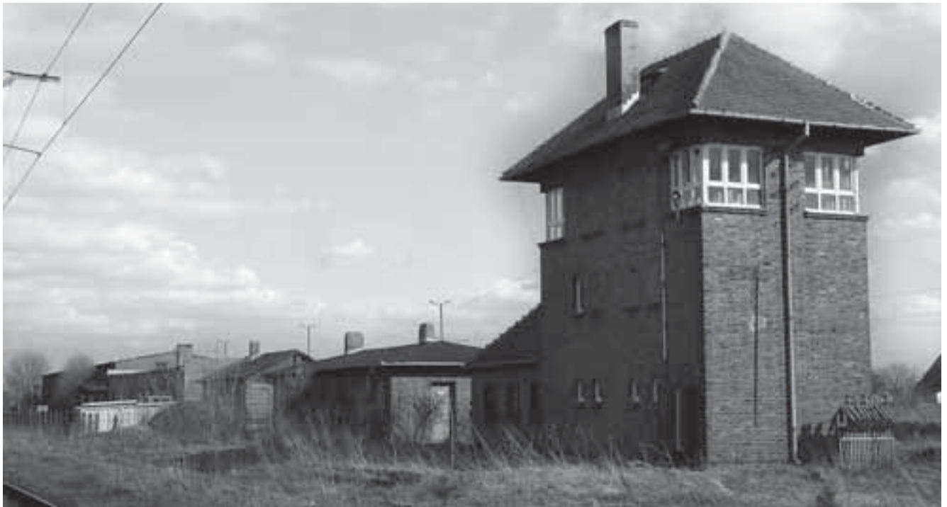
Fot. 183. Kompleks zabudowy towarzyszącej nastawni „Gn-C”. Za nastawnią budynek służbowy Odcinka Drogowego, barak rewidentów wagonów i położony w głębi magazyn wojskowy (fotografia z 2010 r.)
