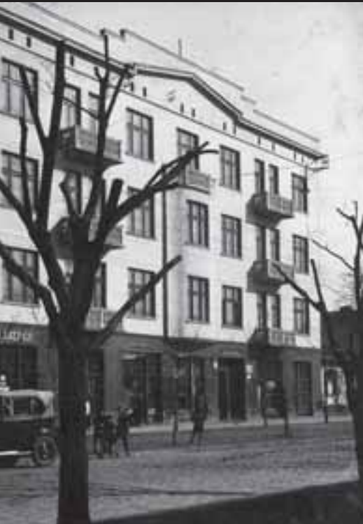
NOWE BUDYNKI PRZY ULICY TEATRALNEJ, LATA 20. XX WIEKU
