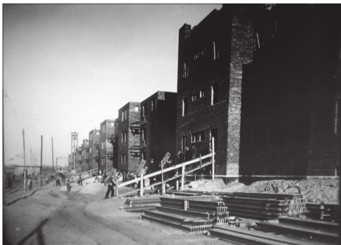
6-8. Osiedle w trakcie budowy
